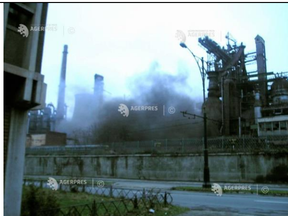
Figură 35 Anul 2004, demolarea furnalului nr. 1 200
